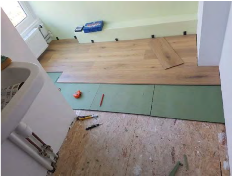
Pand 102 / vervolg renovatie gastenkamer Micha
