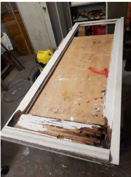
Pand 127-3 / herstel houtrot balkondeur
